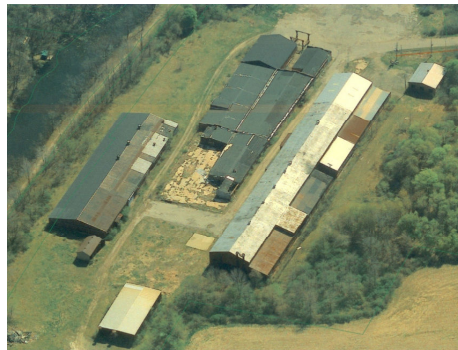
A & A Metal Fabrication Site
