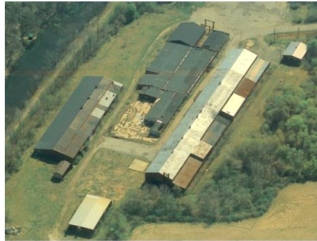
A & A Metal Fabrication Site
